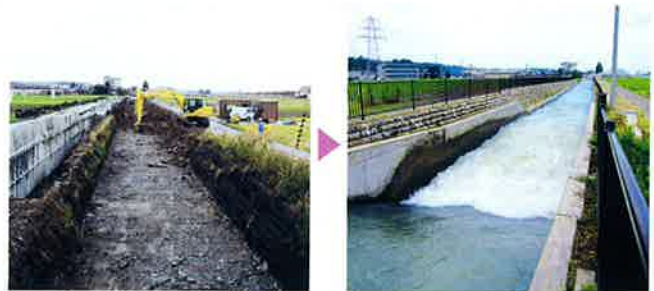
改修前（工事中）
